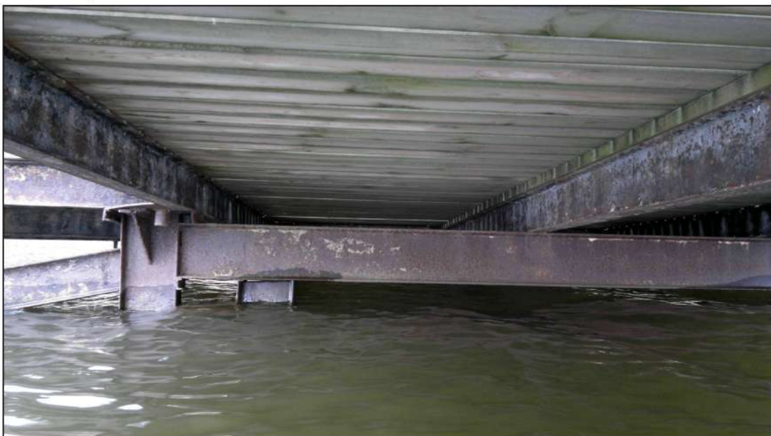
Fot. 3.0 Konstrukcja nośna pomostu w postaci kształtowników stalowych [2.04.2012 r.]
